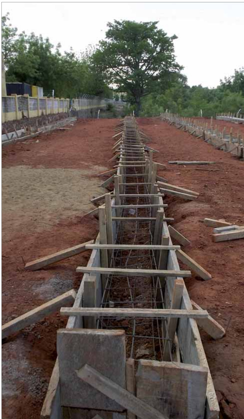
Streifenfundamente im Bau
