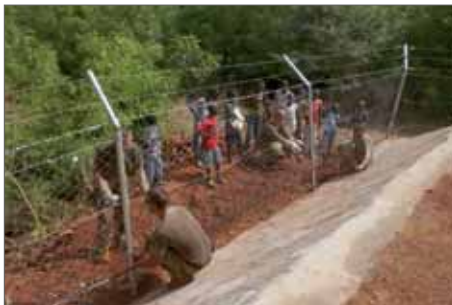
Lagerzaun und Hangabsicherung
