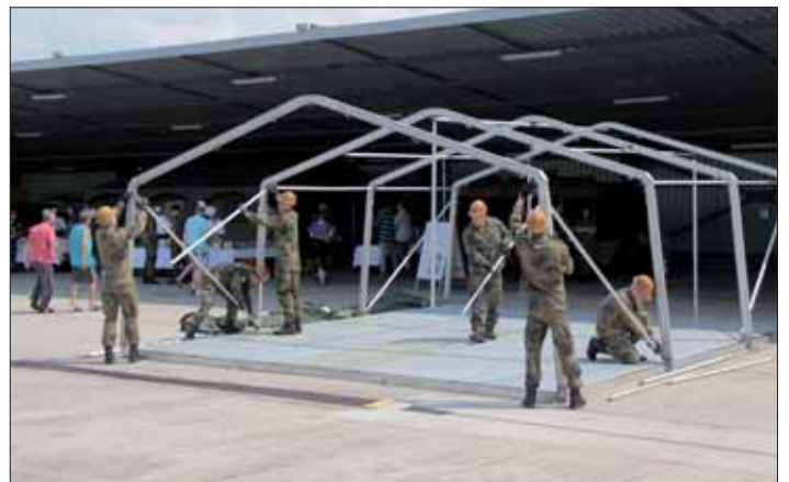
Aufbau Einheitszelt Typ 2
