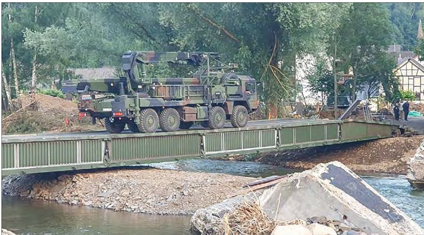
Die Faltfestbrücke in der Katastrophenhilfe im Ahrtal 2021
