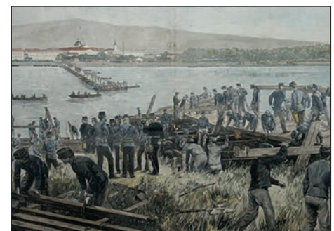
Brückenschlag Mautern Krems, 1893
