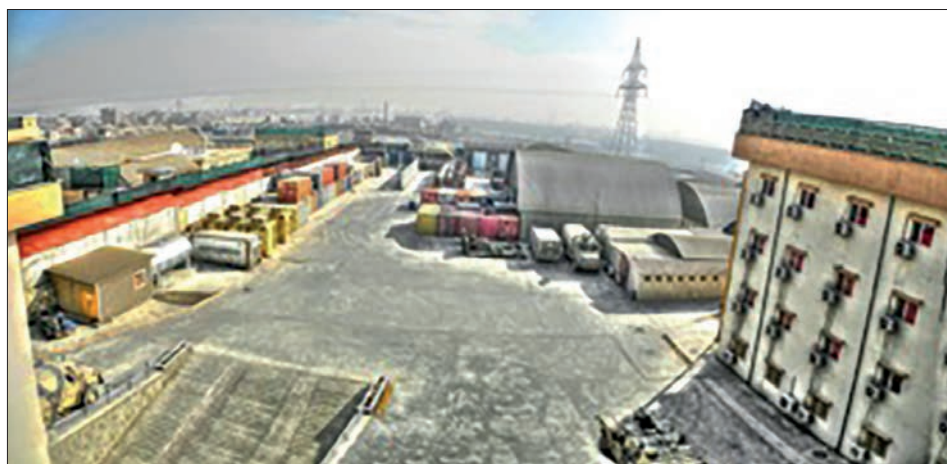
Blick aus der Stellung auf dem Stabsgebäude auf die Zufahrt (1. Linie) und den nördl. Bewegungskanal (2. Linie); unten im Bild links und rechts die beiden nördl. Ambosse
