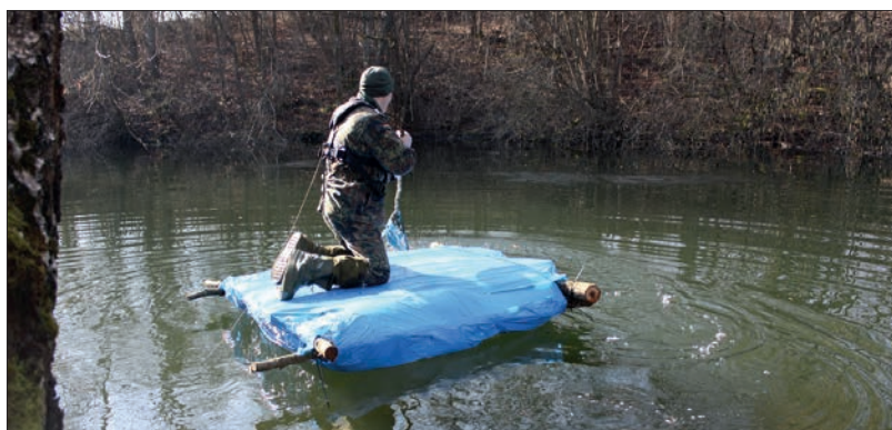
Beim Bau eines Behelfsstegs
