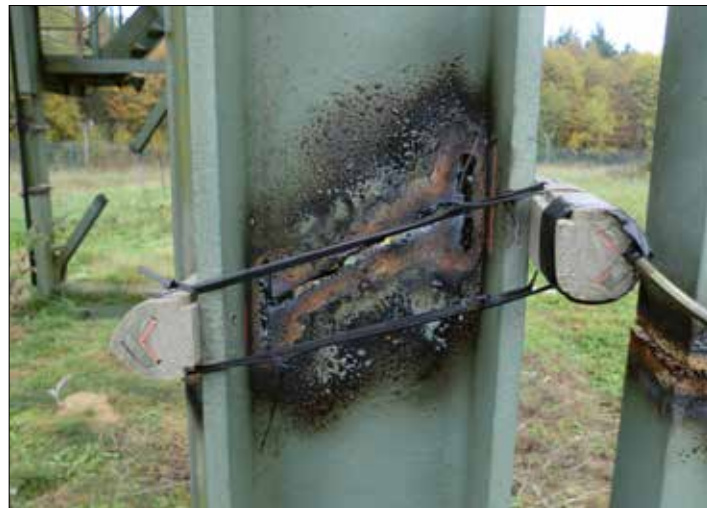
IPB 200 Träger zur Sprengung vorbereitet
