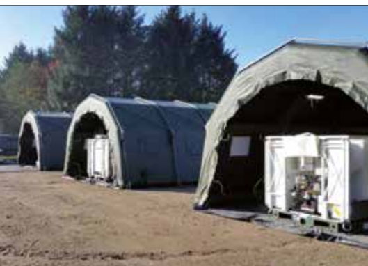
Sanitärbereich in luftgestützten Zelten
