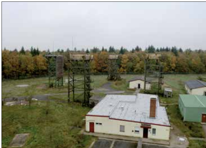
Einige der Sprengobjekte
