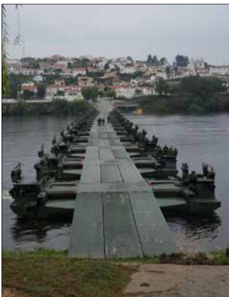
Brückenschluss bei Tancos
