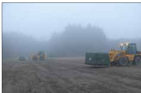
Materialtransport zur Aufbaufläche
