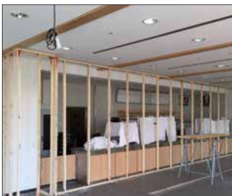
Trockenbauarbeiten am Tresen der ehemaligen HBG
