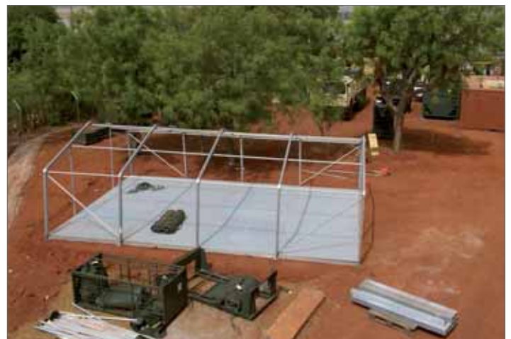
Einheitszelt Typ 2 im Bau
