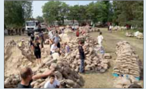
Sandsackbefüllung in Kietz Bild: Bundeswehr
