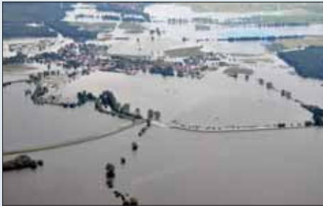
Deichbruch bei Fischbeck Bild: mdr.de
