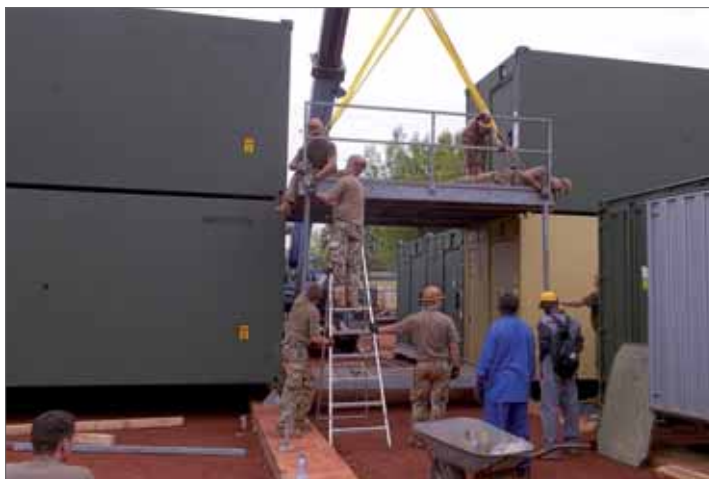
Ein Containermodul wird mit Kran gestellt
