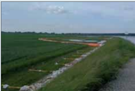
Eine unserer „Baustellen“
