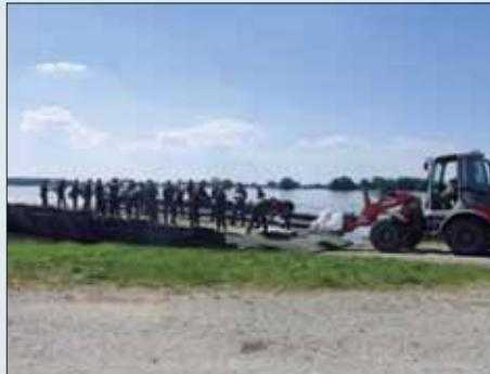
Beladen einer Faltschwimmbrücke mit Sandsäcken Bild: sPiBtl 130
