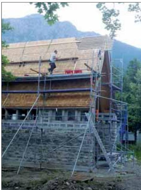
rendaches. Nachdem die gehobelte Dachschalung aufgebracht war, konnte mit Bitumendachbahnen abgedeckt werden. Die Baustelle war winterfest. In Anbetracht der steilen Dachneigung von mehr als 60 Grad, eine respektable Leistung der Zimmerleut'.
