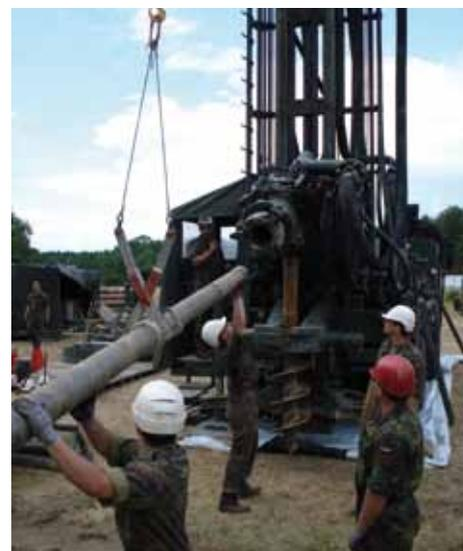
Ansetzen des Bohrgestänges
