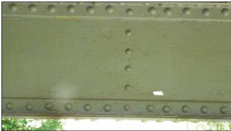
*Fotogrammetrische Messung der Flanschdicke eines Doppel-T-Trägers an schwer zugänglicher Stelle, aufgenommen mit UAV. Bei der Messung wird aus dem bekannten vertikalen Nietenabstand, welcher mit einem Tachymeter ermittelt wurde, auf die Größe eines einzelnen Pixels zurückgerechnet. Über die Anzahl der Pixel kann dann die Flanschdicke errechnet werden. Voraussetzung ist ein rechtwinklig aufgenommenes Foto.*
