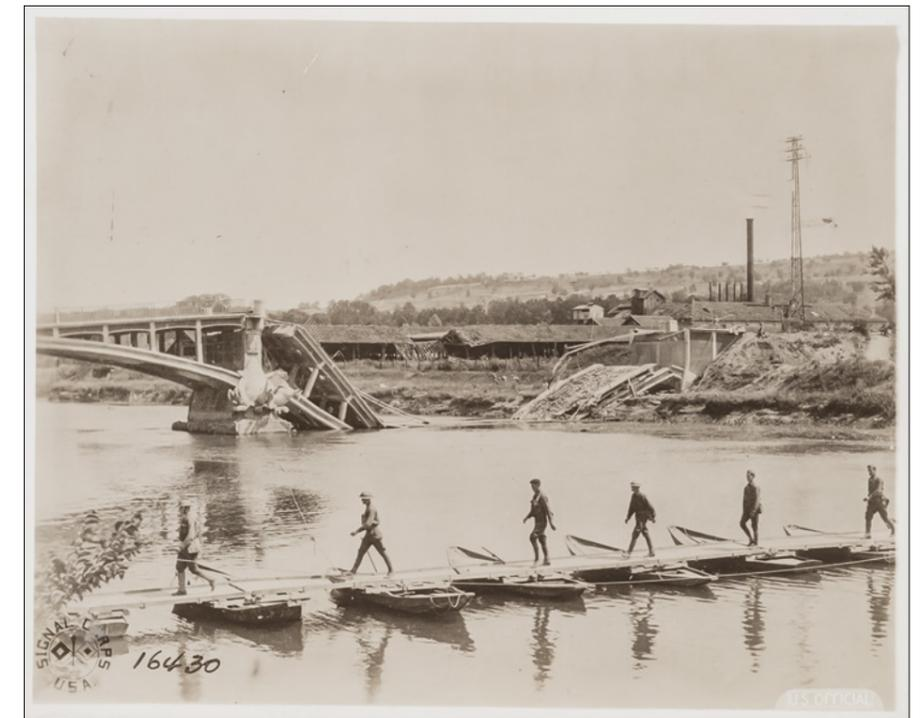
Die erste Pontonbrücke (eher ein Steg) über die Marne, die vom Corps of Engineers bei Lucy, Frankreich, gebaut worden ist. Das Foto zeigt Soldaten des US-Expeditionskorps, die diese Pontonbrücke am 20. Juli 1918 überqueren. Im Bildhintergrund ist die zerstörte Brücke über die Marne zu sehen. Quelle: <https://www.loc.gov/photos/?q=US+France+Corps+of+Engineers+France>
