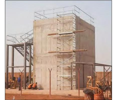
werden, um der Bedien- und Feuerleitzentrale (BFZ) ein klares Bild zu ermöglichen. Schnell entschieden wir uns dazu, die Konstruktion in Stahlbetonbauweise zu errichten. Die innenliegenden Lagercontainer (Foto links) wurden hier als „verlorene Schalung“ verwendet um der Sensorstellung noch mehr Stabilität zu geben.
