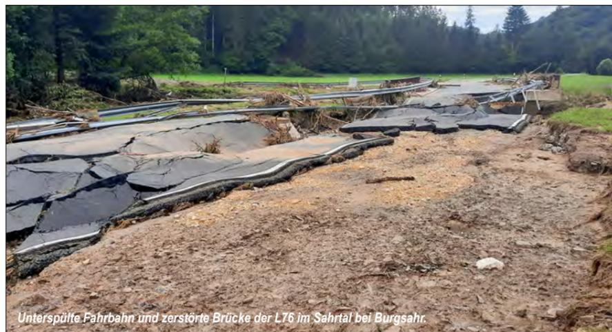
Unterspülte Fahrbahn und zerstörte Brücke der L76 im Sahrtaal bei Burgsahr.
