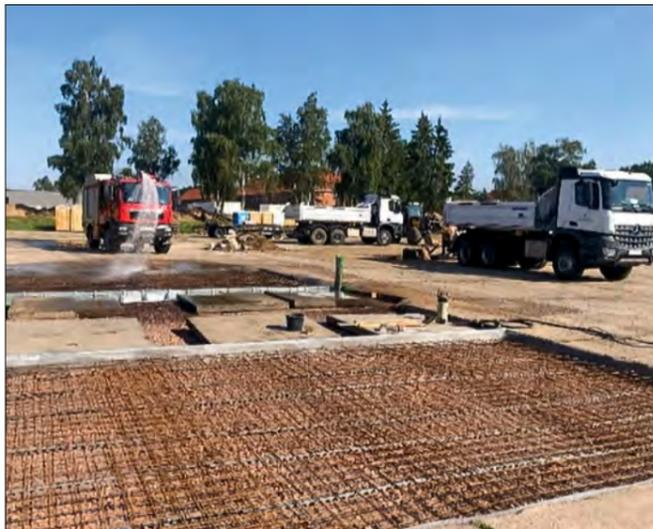
Bewässerung Krater 1 vor der Betonlieferung, fertige Bewehrung und Schalung
