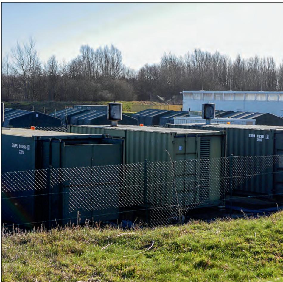
Die unscheinbare Ansammlung von Containern beherbergen die Stromgeneratoren der sogenannten Energieplatte des Pilot-Feldlagers. Hier ist auch die neue dynamische Steuerung im Einsatz.
