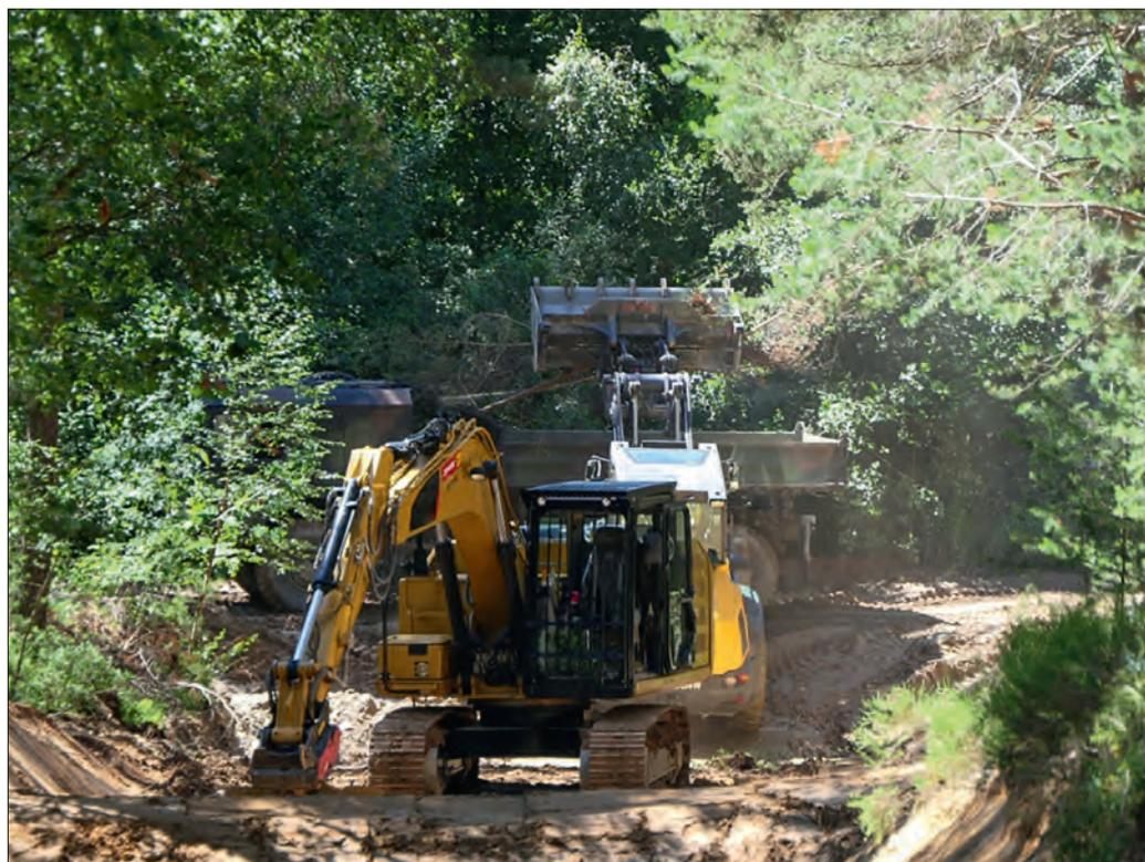
Die alte Strecke wird vorbereitet – der Kettenbagger ebnet den Untergrund, hinten verlädt der Schwenklader kleine Bäume.
