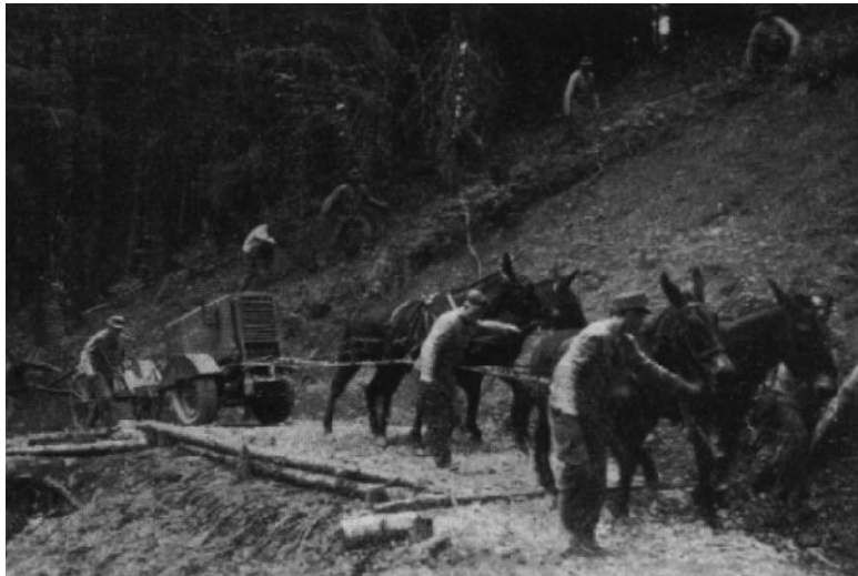
Gebirgspioniere 1934 im Hochgebirge beim Transport eines Kraftbohrgerätes
