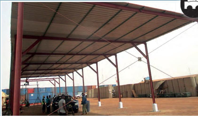
Im Camp Castor wird aktuell unter Aufsicht der Zelle Baukoordination GAO ein Unterstand zum Abstellen von SAN-Kfz errichtet. Die Konstruktion wird aus Stahl von einer einheimischen, malischen Firma hergestellt und befindet sich in den letzten Zügen vor der Fertigstellung.
